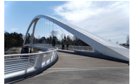
Figure 21 : Passerelle Isoisänsilta en Finlande
