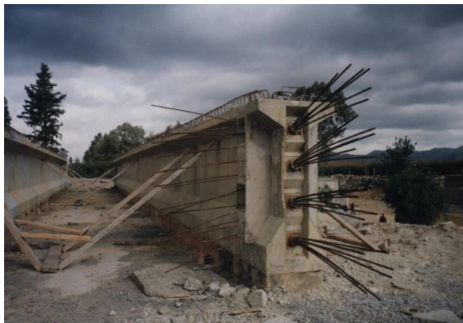
Figure 86 : poutre en béton précontraint
