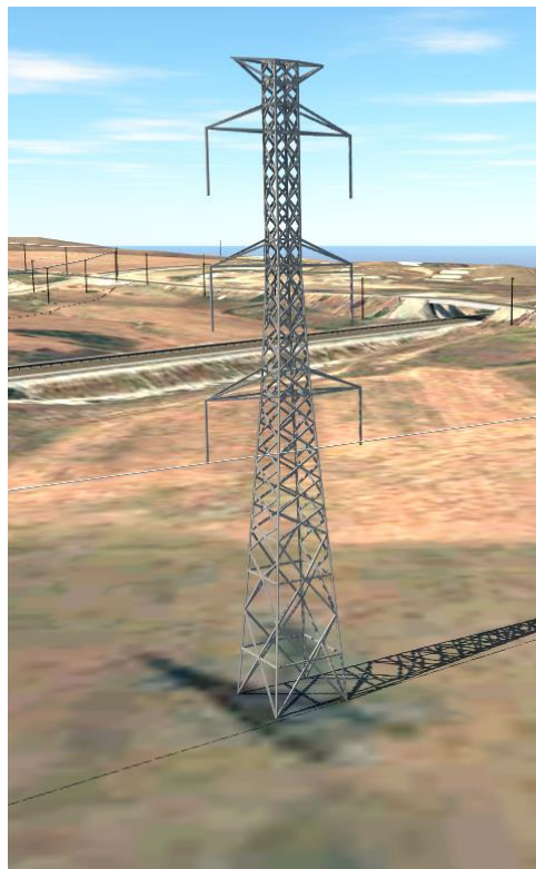
Figure 47 : pylône du réseau THT
