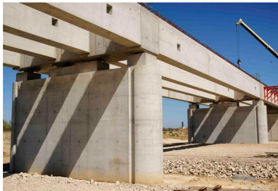
Figure 85 : pont à poutres en béton armé
